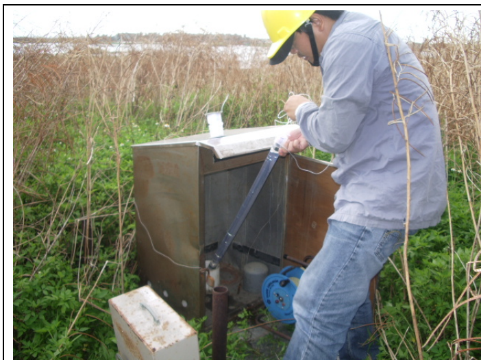
SS01(貝勒管取水)
