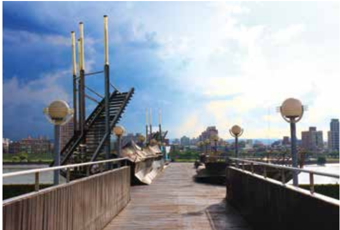
大地重現陸橋
