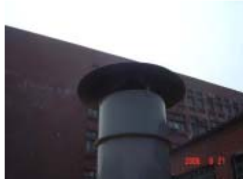
1. 抽氣量 13.1 m 3 /min，循環水量 Q_L = 60 L/min，排氣口粒狀物濃度約 60 mg/m 3
