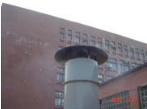
3. 抽氣量 26.3 m 3 /min，排氣口粒狀物濃度約 115 mg/m 3
