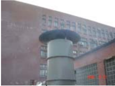
1. 抽氣量 13.1 m 3 /min，排氣口粒狀物濃度約 140 mg/m 3
