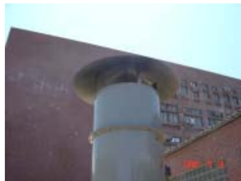
3. 抽氣量 26.3 m 3 /min，循環水量 Q_L = 40 L/min，排氣口粒狀物濃度約 85 mg/m 3
