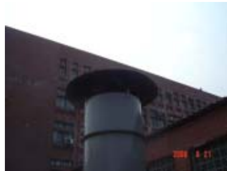
2. 抽氣量 26.3 m 3 /min，循環水量 Q_L = 60 L/min，排氣口粒狀物濃度約 50 mg/m 3
