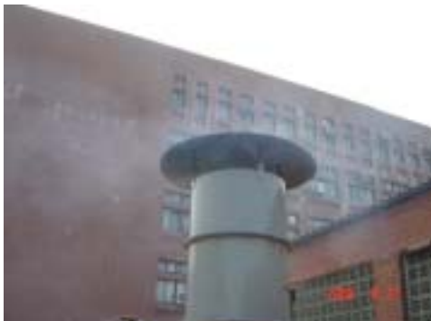
2. 抽氣量 13.1 m 3 /min，排氣口粒狀物濃度約 190 mg/m 3
